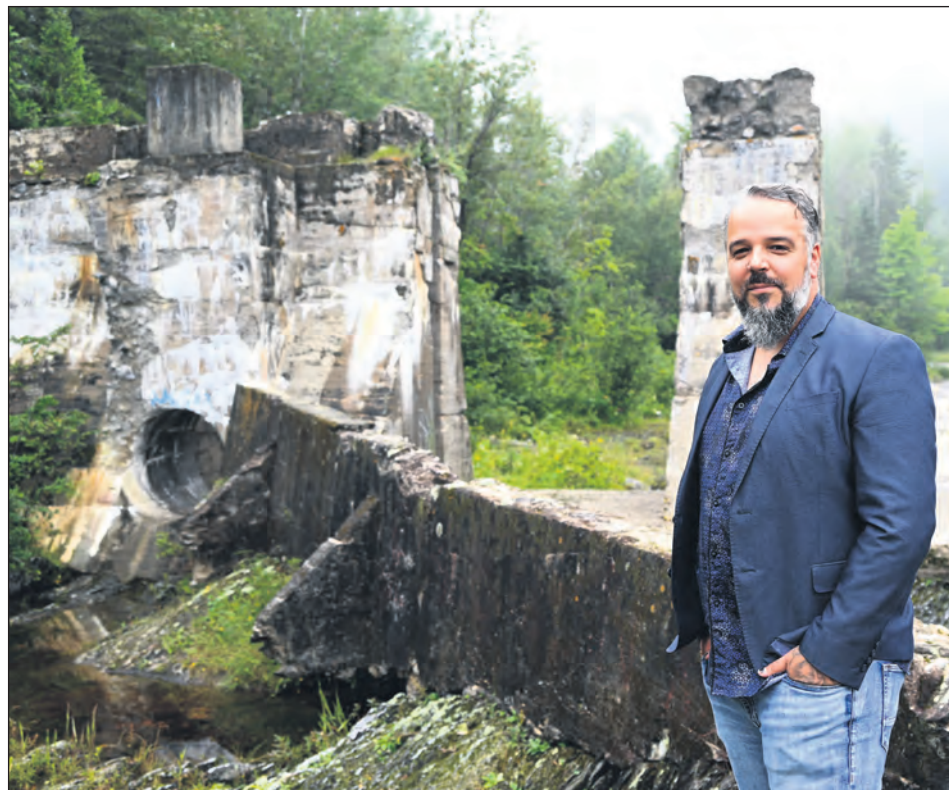
Dany Larrivée devant le Barrage de la Compagnie électrique du Témiscouata, un des sites du parcours historique. PHOTO: LYDIA BARNABÉ-ROY
