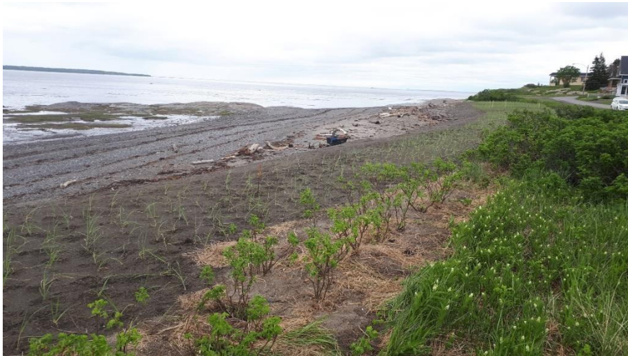
Plage de la rue de la Grève restaurée à Notre-Dame-des-Neiges
