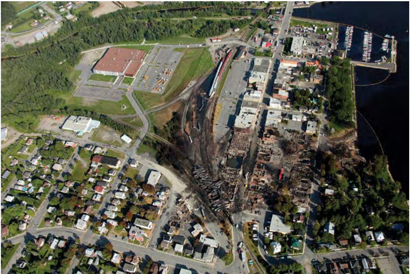
Catastrophe ferroviaire, Lac-Mégantic, 2013 (Photo : Sûreté du Québec)
