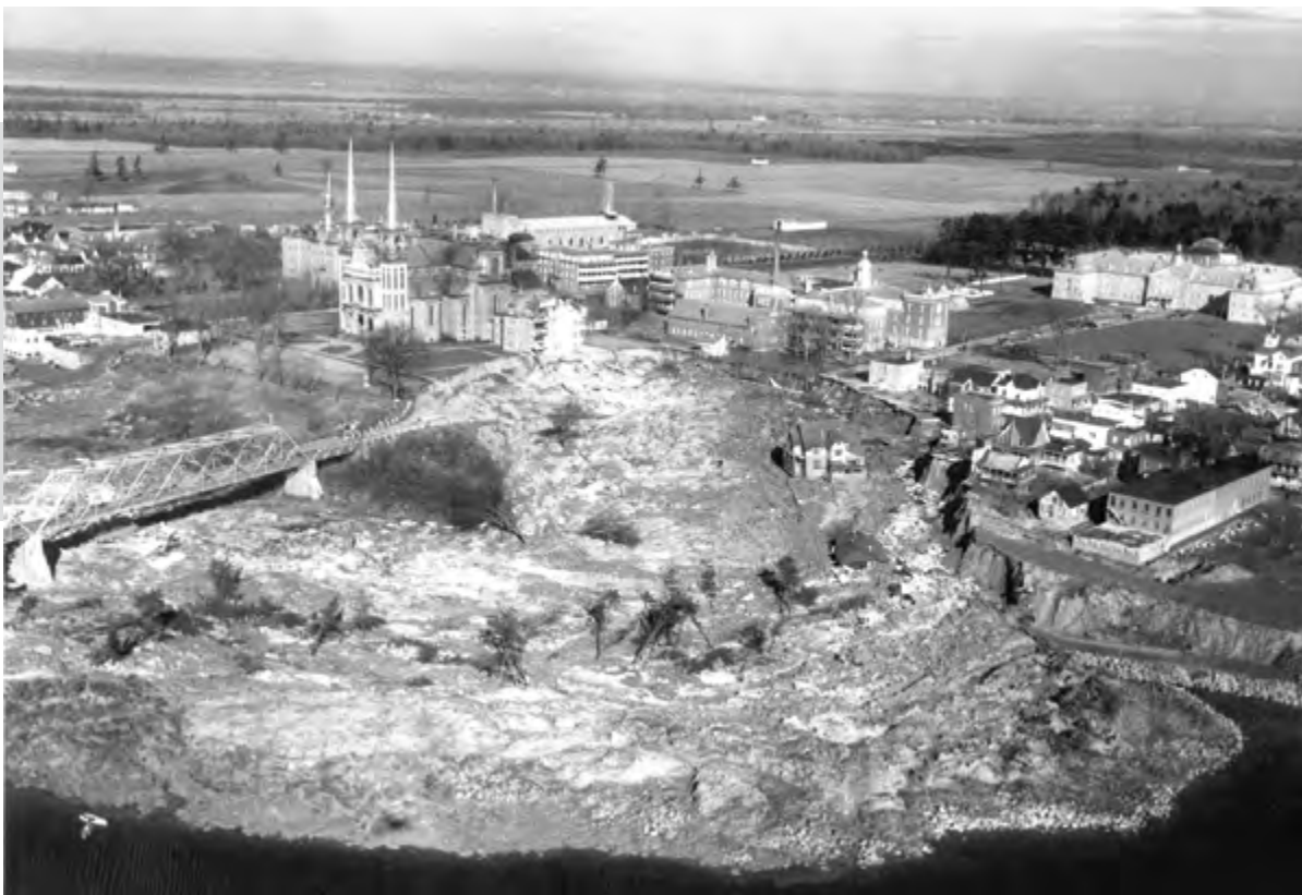
Glissement de terrain, Nicolet, 1955
